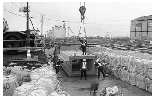
写－3 函渠工の施工
