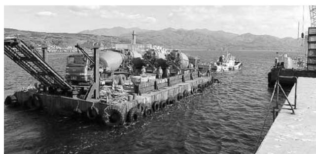
写-3 上部コンクリート海上運搬
