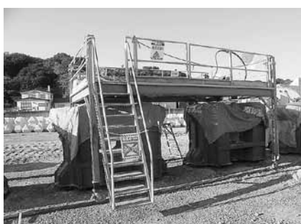
写-2 移動式足場
