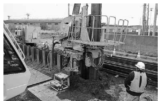
写－2 仮設鋼矢板打込み
