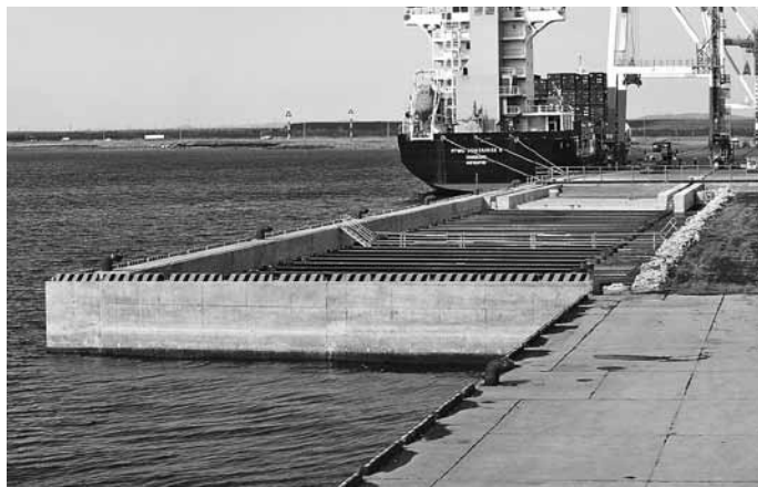
苫小牧港東港区岸壁－12m控工外建設工事
