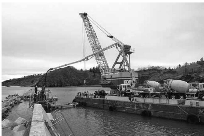
厚岸漁港門静地区物揚場その他工事
