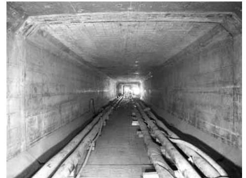
函渠内部状況
