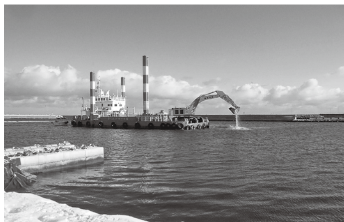
森港建設工事
