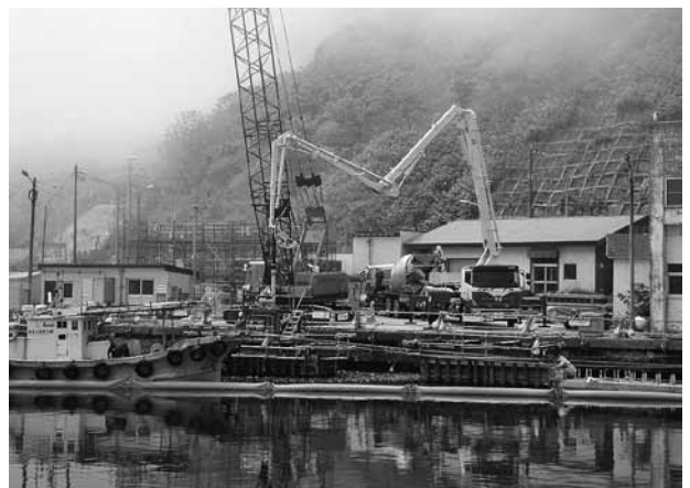
余別漁港－2.0m物揚場改良その他工事
