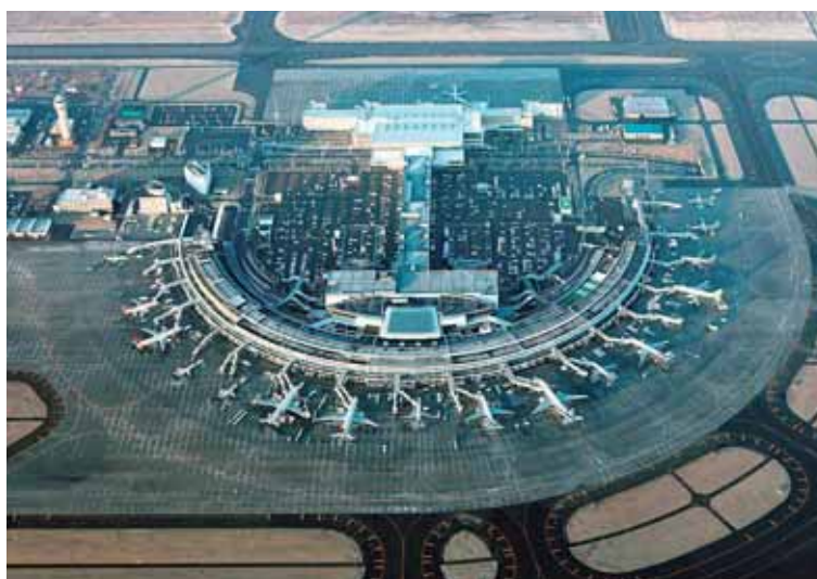
新国際線ターミナル、国内線ターミナルを結ぶ連絡通路
