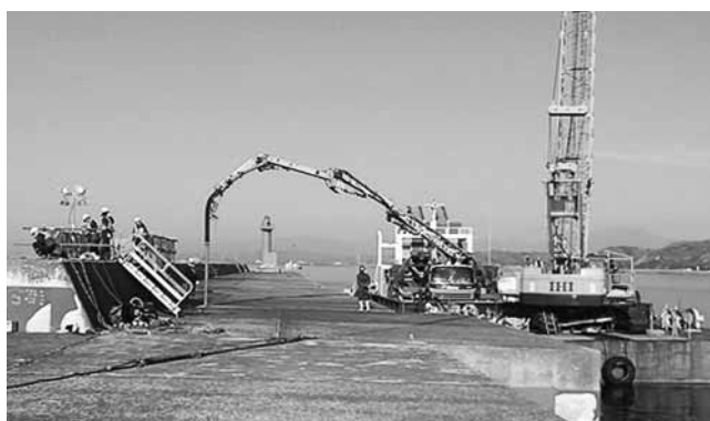
江差港 水中不分離コンクリート注入状況
