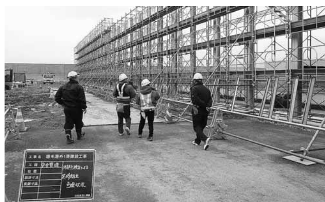
外部点検者による足場点検
