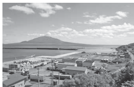
完成した耐震強化岸壁
