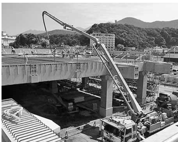
トップコンクリート打設作業
