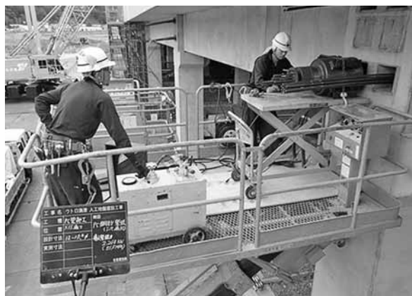
最終PCケーブルの緊張作業
