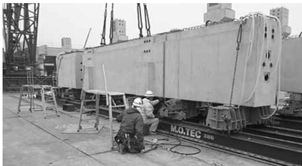
大梁連結作業
