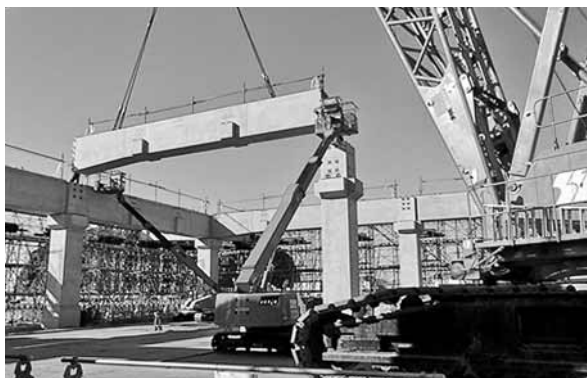
大梁架設作業
