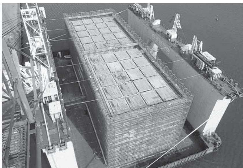
ケーソン製作の全景
