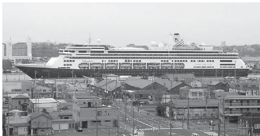
釧路港東港区耐震旅客船ターミナルに接岸した「フォーレンドム」
