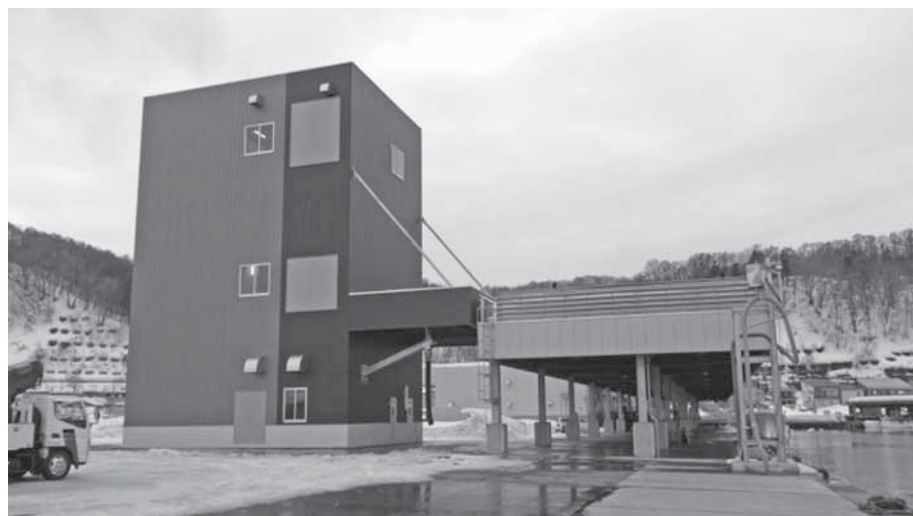
屋根付き岸壁と荷さばき施設に隣接する製氷・貯氷施設
