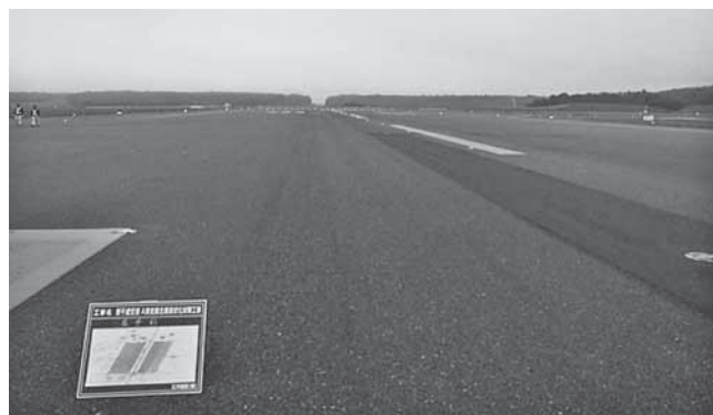
写真-2 施工箇所（着工前）
