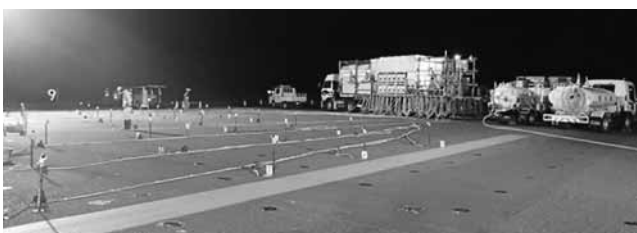
写真－6 浸透固化注入状況
