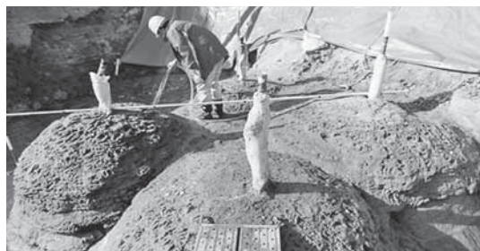
写真-3 浸透固化処理工法（改良体）
