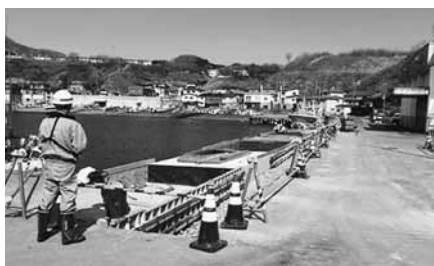
工事現場の点検・確認
