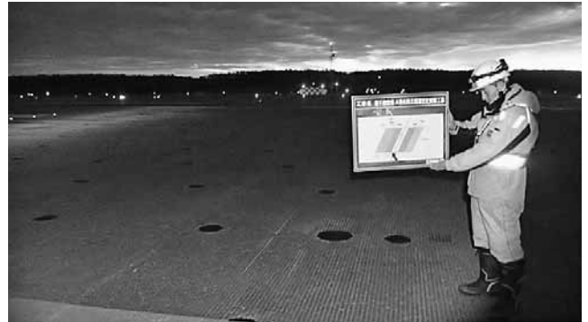
写真－7 完了全景状況
