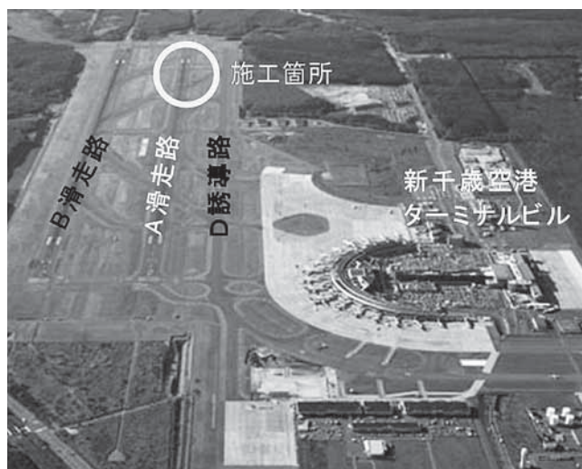
写真-1 新千歳空港 施工箇所
