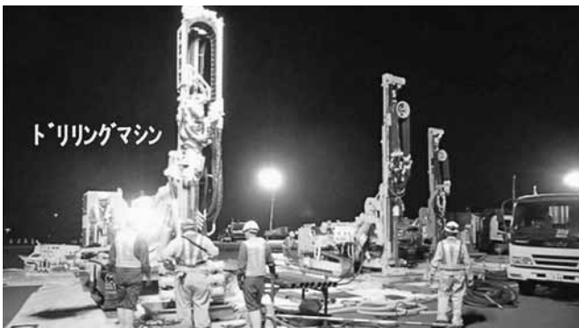
写真－5 削孔等作業状況
