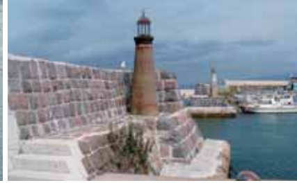
石積防波堤(南側)
