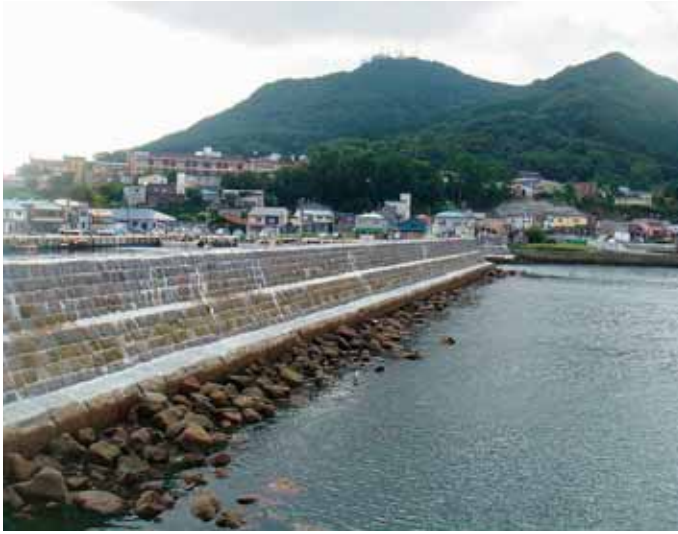
石積防波堤(北側)と函館山
