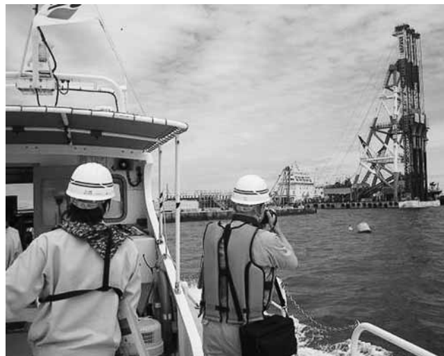
港湾業務艇「ひまわり」から施工状況を視察
