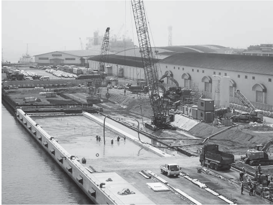
改良工事状況
