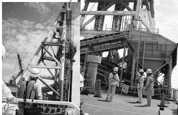
船上及び港湾業務艇からリーダー及びケーシングを瞻仰
