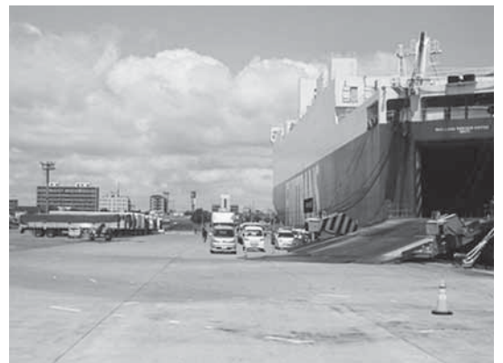
改良後の西ふ頭－9 m耐震強化岸壁
