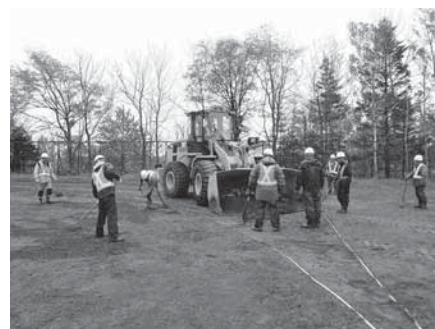
小学校グラウンド整備
