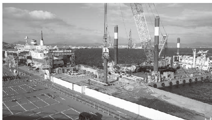
鋼管杭打設φ1300（陸上部）
