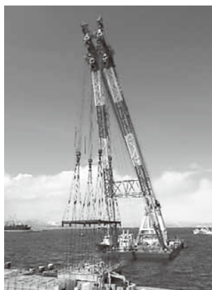
受梁ブロック据付状況
