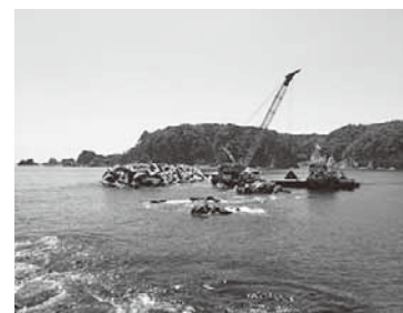
田老漁港災害復旧工事
