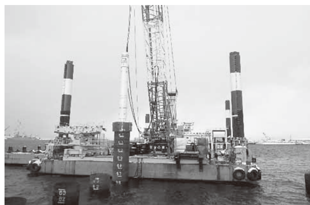
鋼管杭打設φ1500（海上部）
