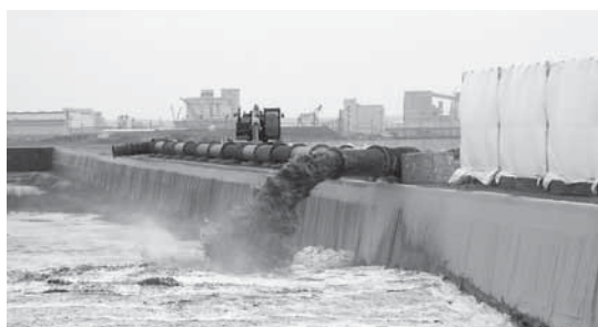
写真－3 陸上揚土状況
