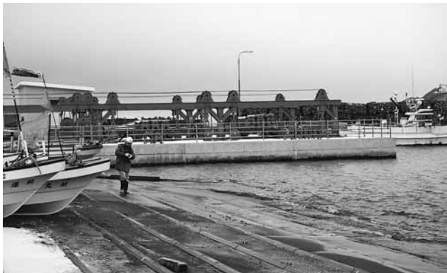
浦河港 施設点検
