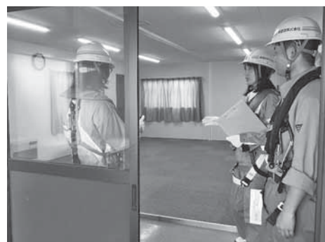
現場事務所周辺の点検
