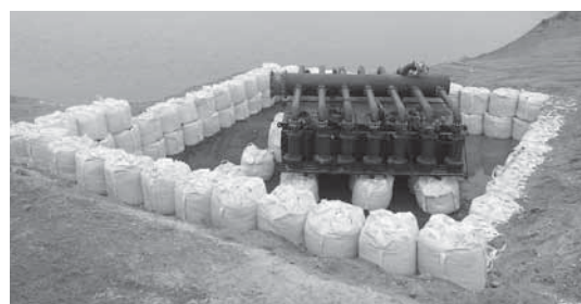
写真－6 取水ポンプ付台船設置状況
