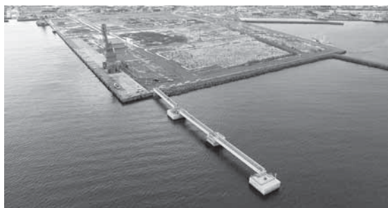
係船柱（ビット）整備状況（H30.11.26）
