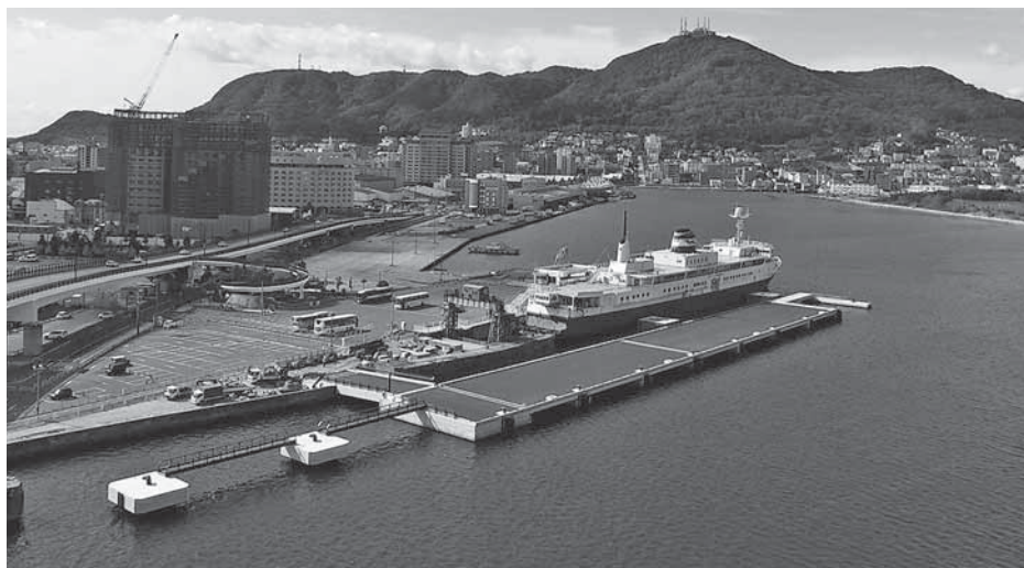
延長225m整備完了状況
