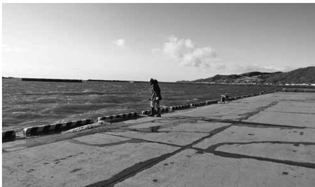
浦河港 ー7.5m岸壁点検(広域防災フロート係留場所確認)
