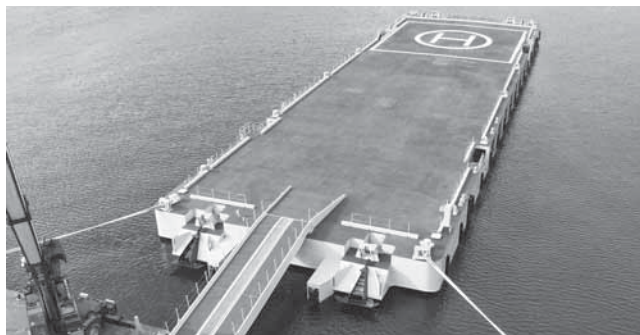
広域防災フロート
