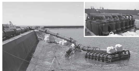
写真－5 循環用取水ポンプ付台船
