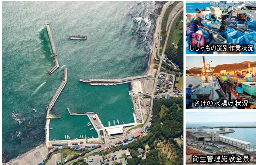
[写真提供：室蘭開発建設部]
