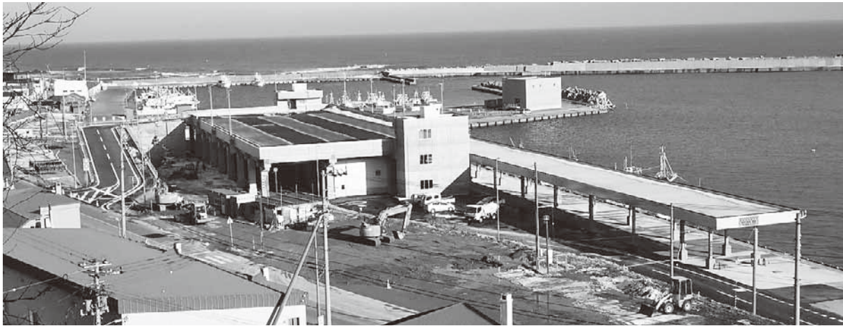
衛生管理施設全景
