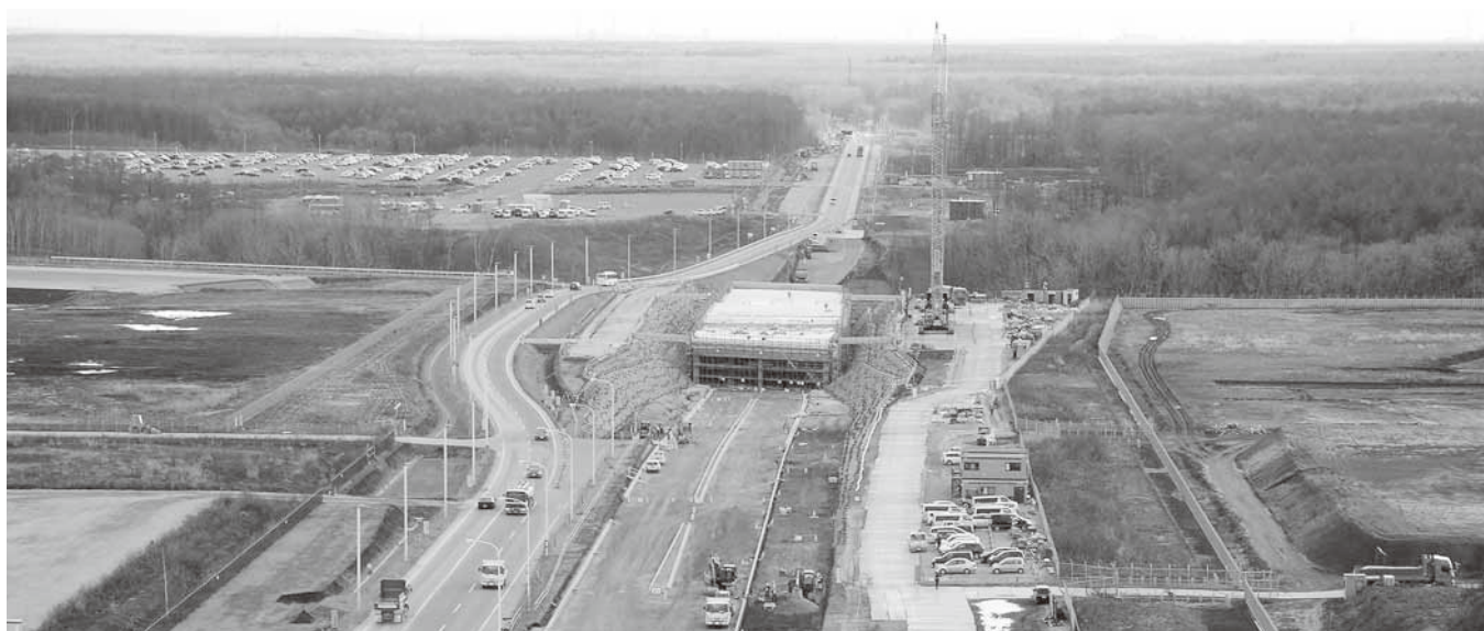
写真1 管制塔からの全景
