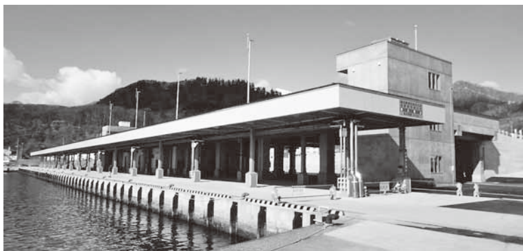
屋根付き岸壁
