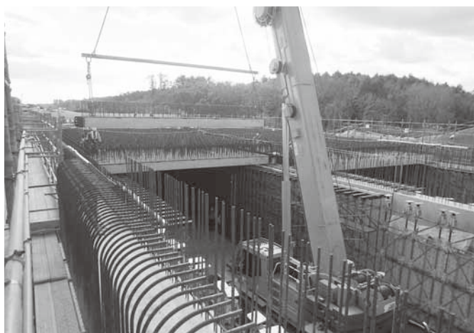
写真2 PC頂版架設状況
