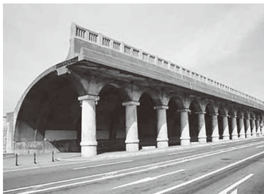
写真1 稚内港北防波堤ドーム
