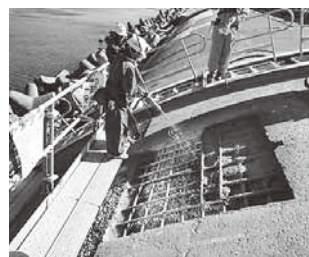
写真3 床版部モルタル吹付作業状況
