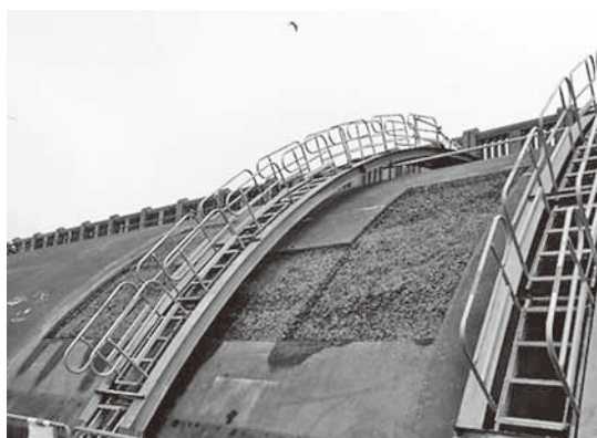
写真5 作業用曲面足場設置状況
