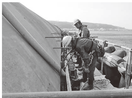
写真4 胸壁部コンクリート打設状況
