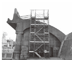
写真7 昇降足場設置状況
