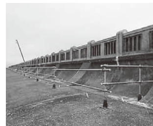
写真8 現場内通路設置状況
