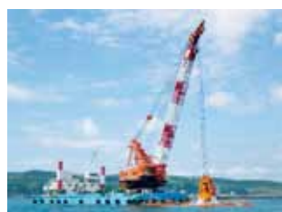
浚渫工事実施状況
