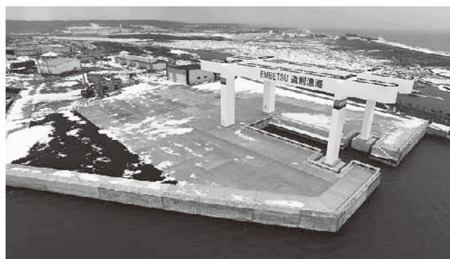
船揚場完成時
