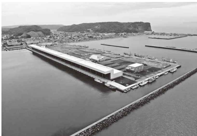
屋根付き岸壁全景
