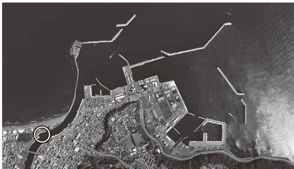
航空写真（丸囲みが物揚場（-3m））
