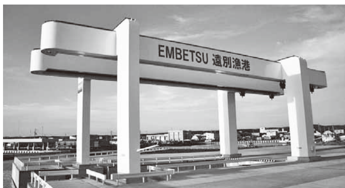
船揚場完成時
