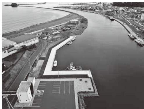
完成した物揚場（-3m）と網走川右岸側
