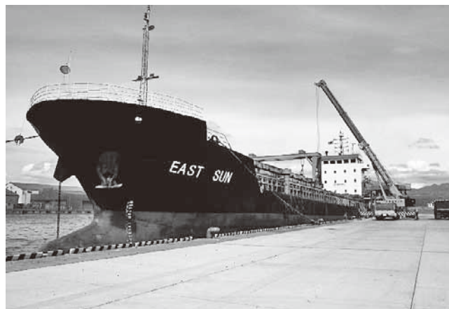
事業完了後の利用状況(化学肥料の荷下ろし)
