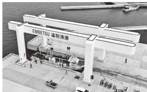
クレーン上架状況
