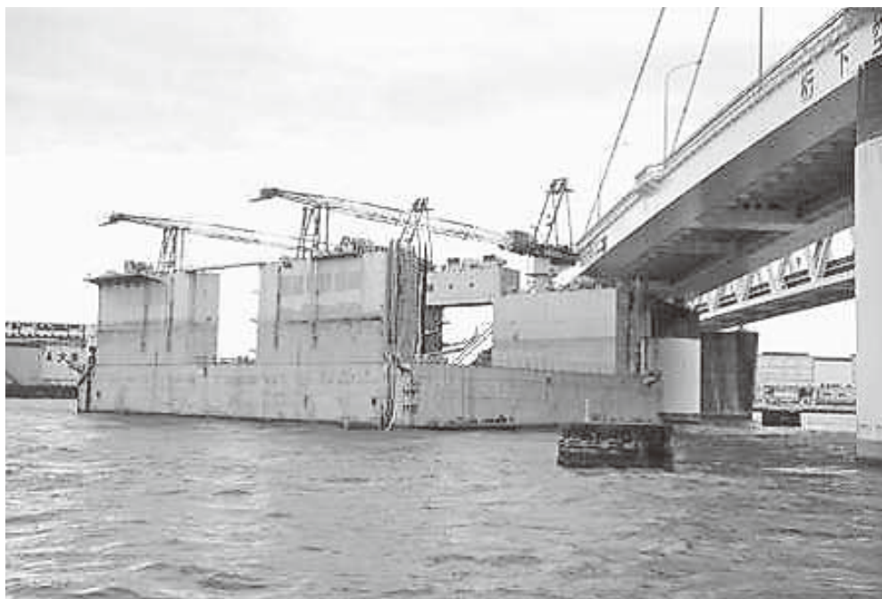
写真-1 2019年台風15号横浜港大黒大橋FDの衝突 (国土交通省港湾局資料)
