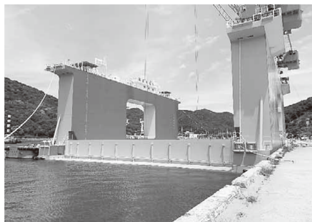
写真2 防潮ゲート建て込み状況
