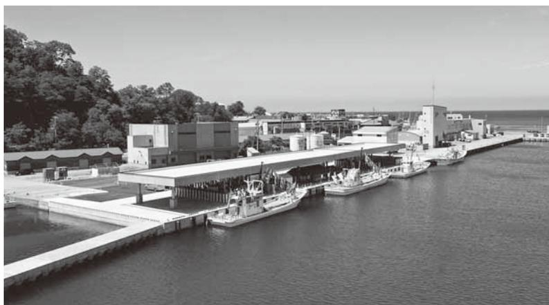
完成した屋根付き岸壁（物揚場-3.5m延長90m）
