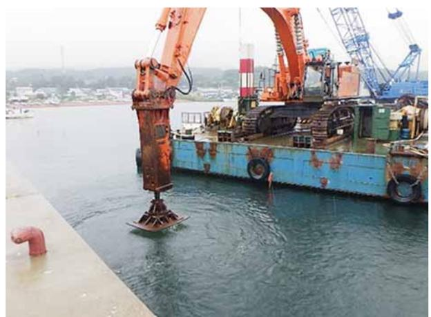
既設基礎捨石天端撤去・捨石投入後、
