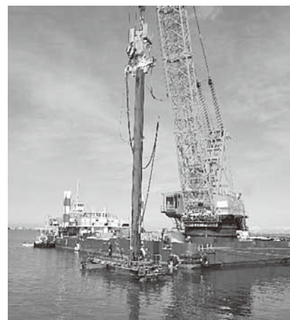
控え鋼管矢板の打設状況（1本目）
