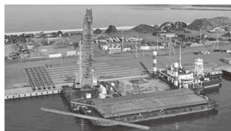
鋼管矢板の荷下ろし状況（東ふ頭）
