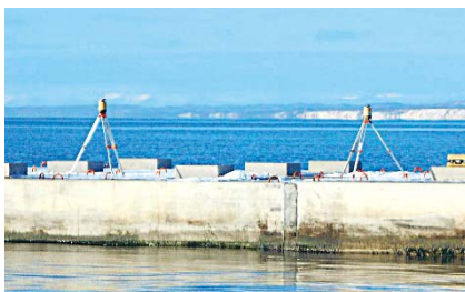
自動追尾型トータルステーション(2台)設置
