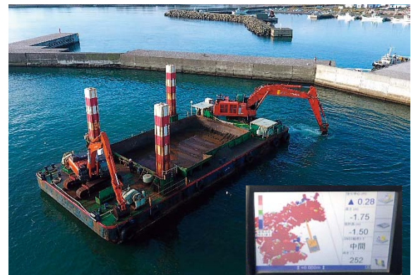
3Dマシンガイダンスシステムを活用したバックホウ船による捨石荒均し
