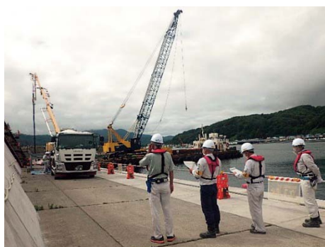
店社安全パトロールの状況
