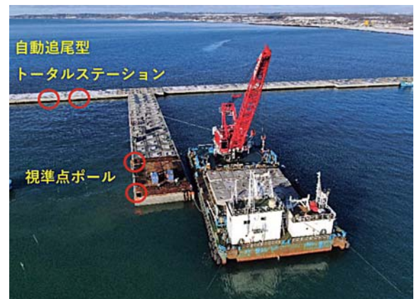
自動追尾型トータルステーション施工状況
