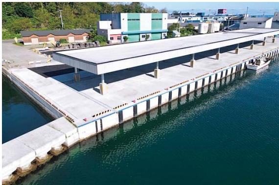
完成した屋根付き岸壁
