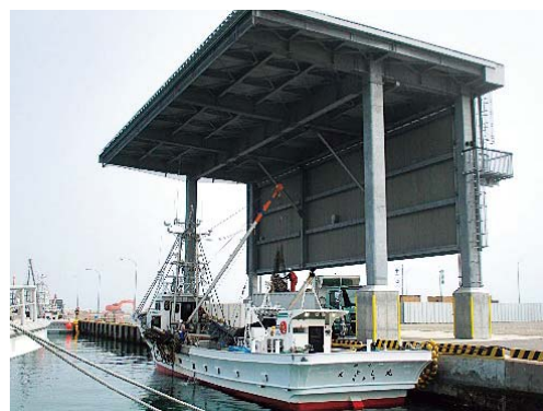
屋根施設整備後のホタテ水揚げ状況
