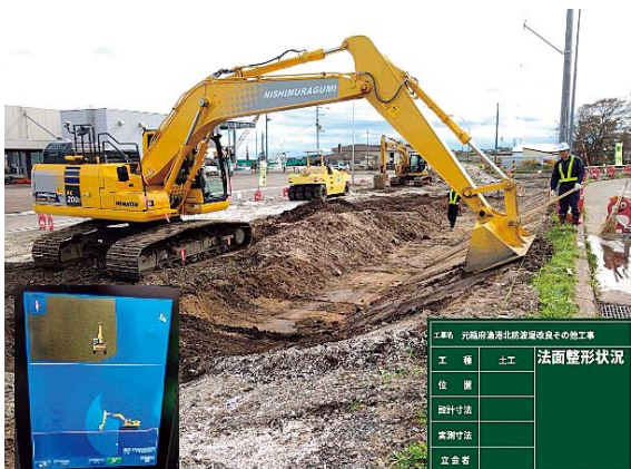
3D-MCバックホウによる施工
