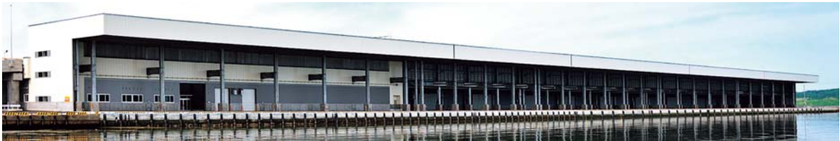
屋根施設全景
