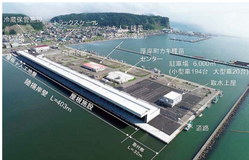
衛生管理施設全景
