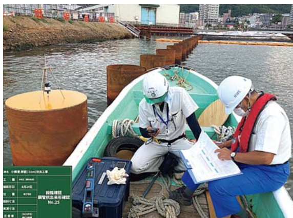
端末アプリによる出来形確認状況
