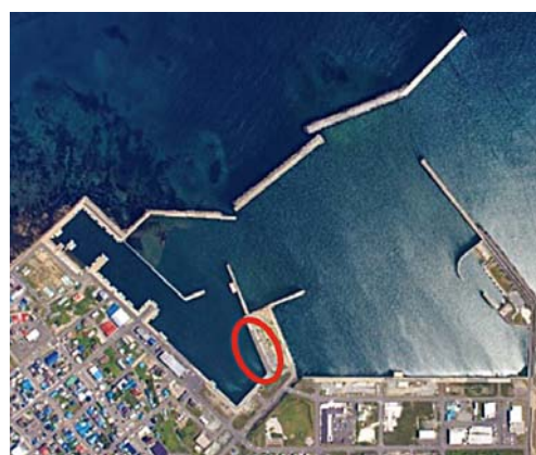
航空写真（丸囲みが屋根施設整備箇所 （物揚場(水深3.5m)(中央)(改良)））
