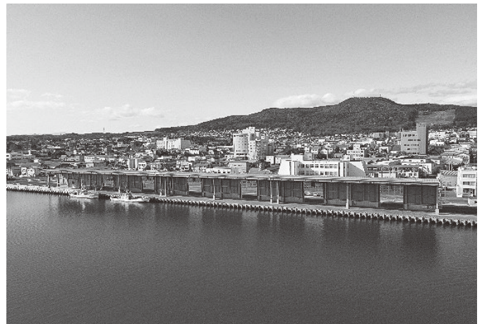
屋根付き岸壁
