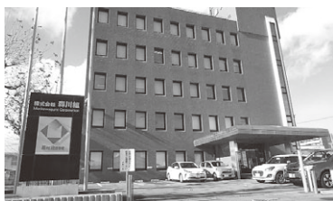
(緊急時避難ビルとして開放する森川組本社)
