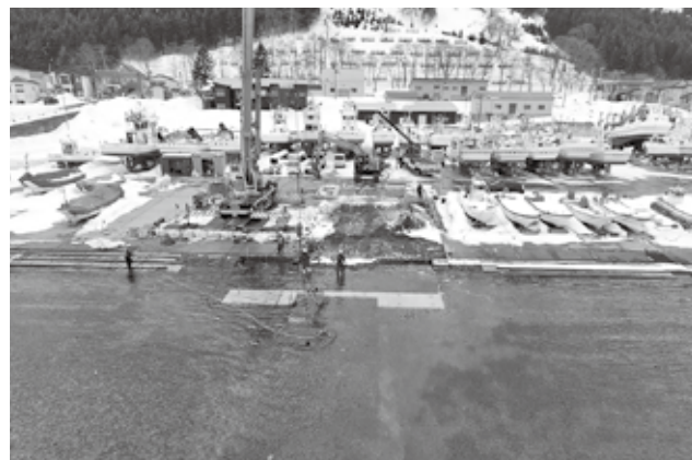
工事状況写真
