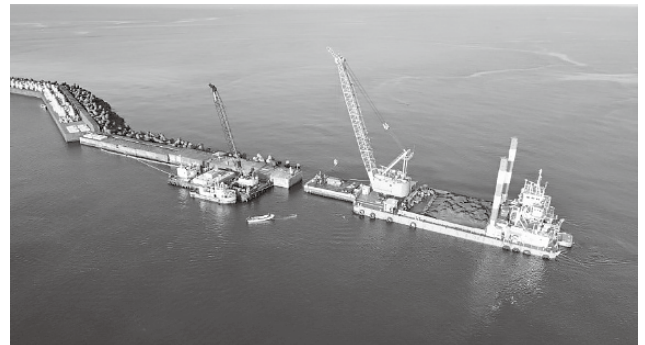
西外防波堤ケーソン据付
