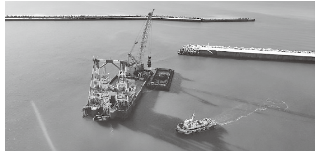
ー 6 m航路浚渫
