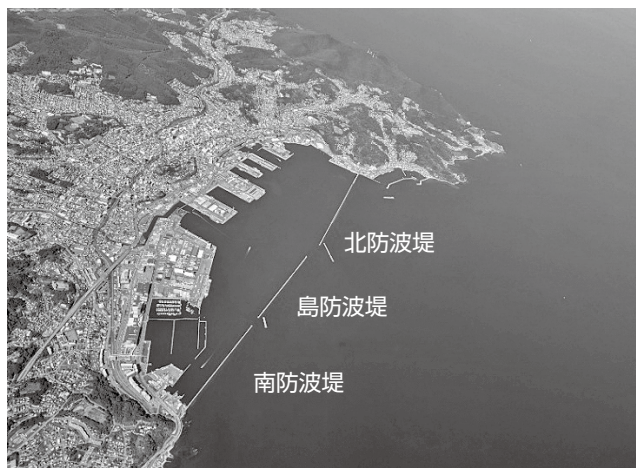
写真-1 小樽港防波堤施設
