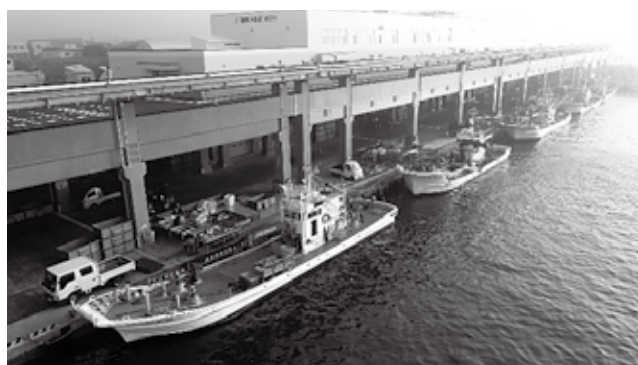
屋根付き岸壁での陸揚げ状況
