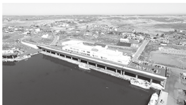
歯舞漁港人工地盤関連施設の全景
